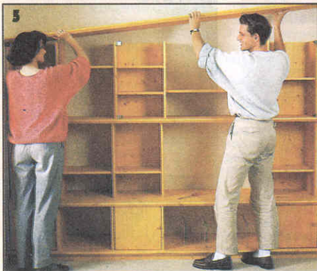
...на которой монтируют еще один ряд секций.
